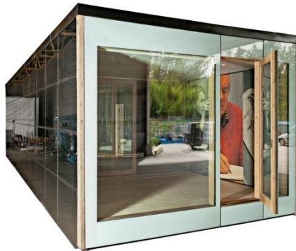
Långsida klädd med fasadintegrerade solpaneler och helglasad kortsida. Foto: Bertil Hertzberg
