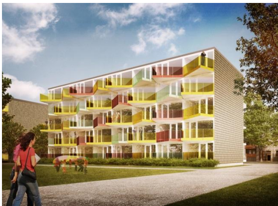
Bostadsprototyp 1.0 sammanbyggt till ett loftgångshus. Fasad av granspån, glasade balkonger i olika kulörer. De spetsiga balkongerna möjliggör större balkonger med bibehållet dagsljusintag. Illustration: Tengbom, ritning: NOOA
