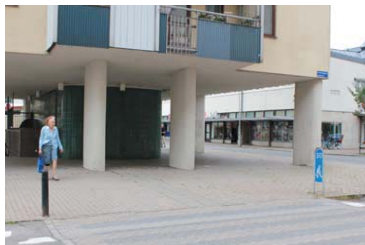
Bild 16. Betongstommens möjligheter accentueras i den öppna entrévåningen.
