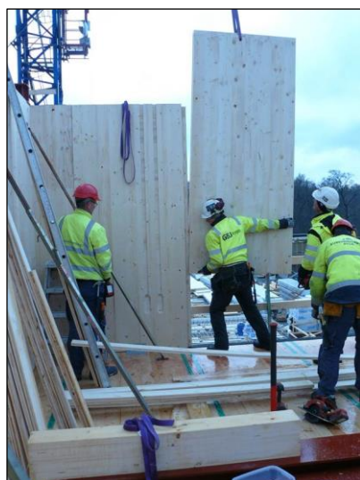
Figur 26. Montage av halvformatselement vid GBJ:s byggprojekt Brf. Strandsnäckan, Växjö.
