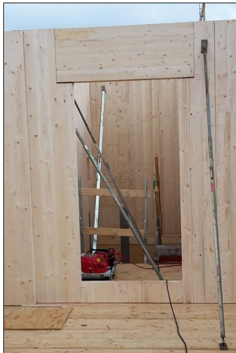
Figur 28. Anpassning av väggelement av halvformat vid håltagning för dörr, Brf. Strandsnäcken, Växjö.
