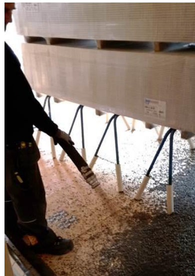
Figur 23. Stegljudisolering på CLT-bjälklag: a) bjälklagsuppbyggnad, b) grusmaterial som sprids ovanpå CLT-bjälklag, och c) spridning av grusmaterial med hjälp av "blåsning".
