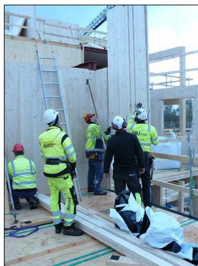
Figur 26. Montage av halvformatselement vid GBJ:s byggprojekt Brf. Strandsnäckan, Växjö.
