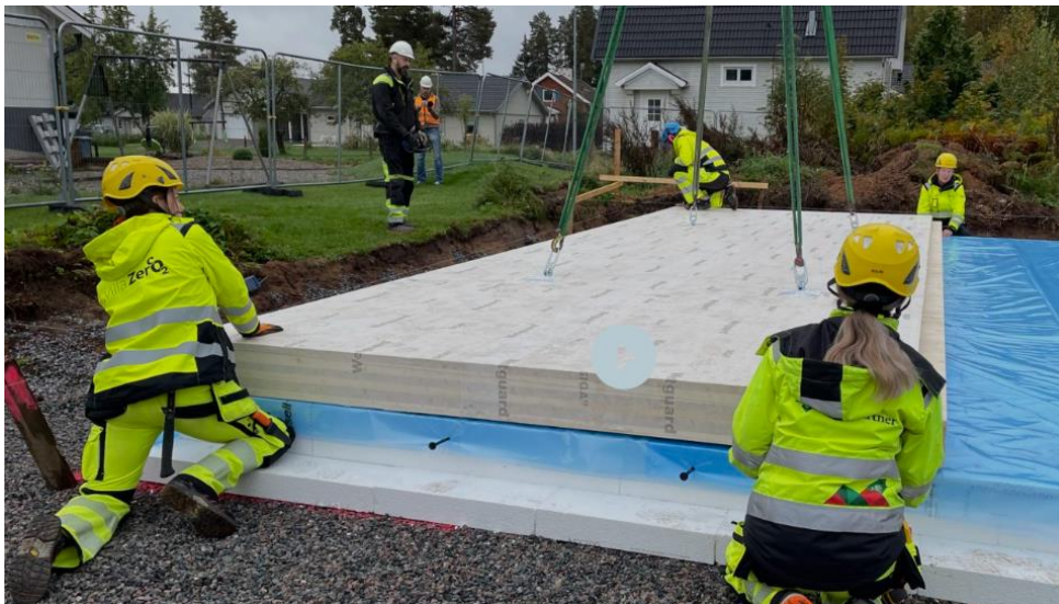
Figur 1. Montering av trägrundläggning, Fiskarhedenvillan Villa ZERO, 2022
