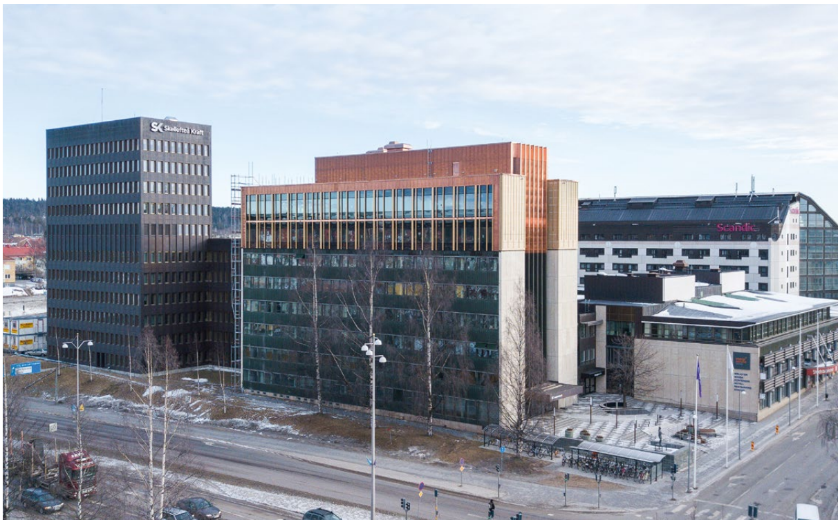
Skellefteå Kraft kontorshus med påbyggnad av två våningar med stomme i KL-trä och limträ.
