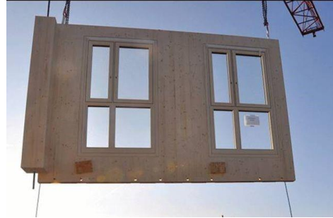
Figur 8 Stabiliserande väggskiva under montage
