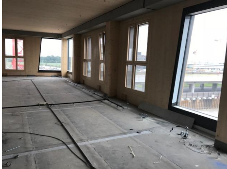
Figur 7 Samverkansbjälklag trä och betong
