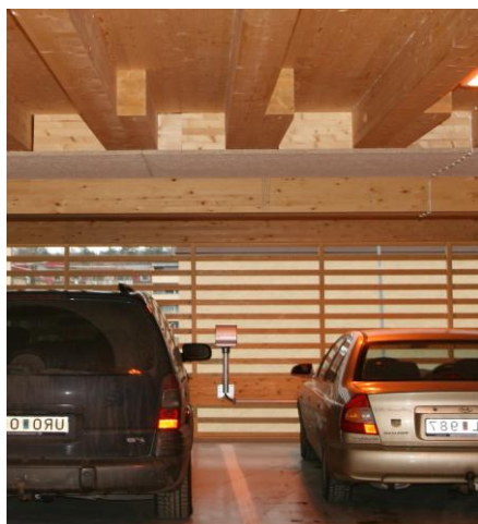
Figur 2 Samverkanskonstruktion mellan KL-trä och limträ. Del av pelar-balkstomme i parkeringshus.
