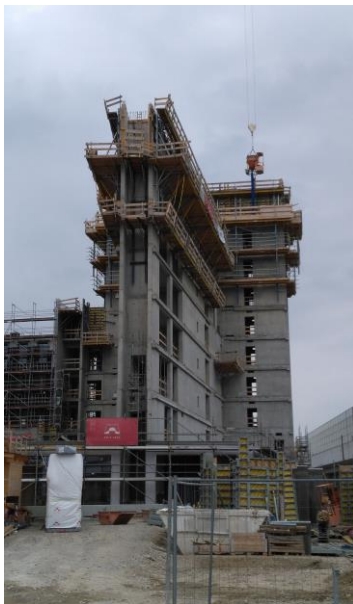
Figur 9 Stabiliserande kärna av betong
